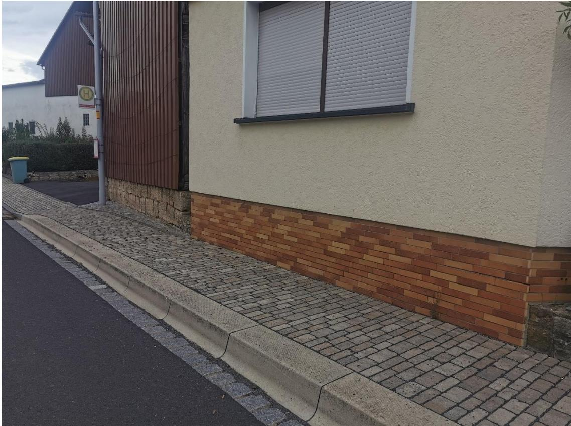
*Abbildung 38: Beispiel für ausgebaute Haltestelle mit Nichterfüllung der Anforderungen an die vollständige Barrierefreiheit (Haltestelle Ahlstadt)*
