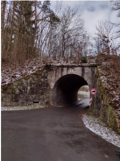
Eisenbahnüberführung Tunnel Görzdorf
